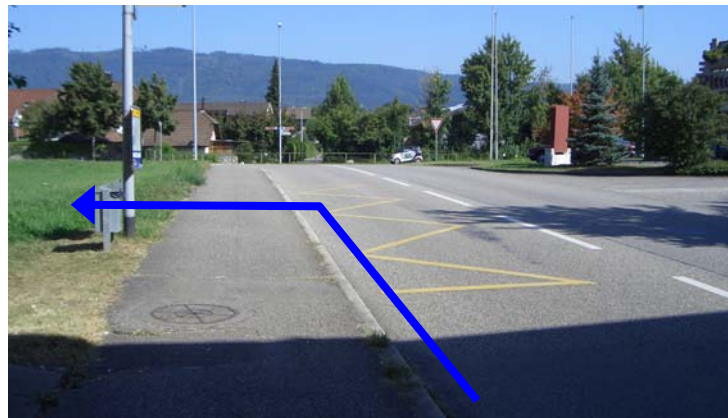
Abb. 19: Unterführung Stein Chälleracher, Blickrichtung nach Norden. Fliessrichtung nach links (Westen) über Trottoirrand.
