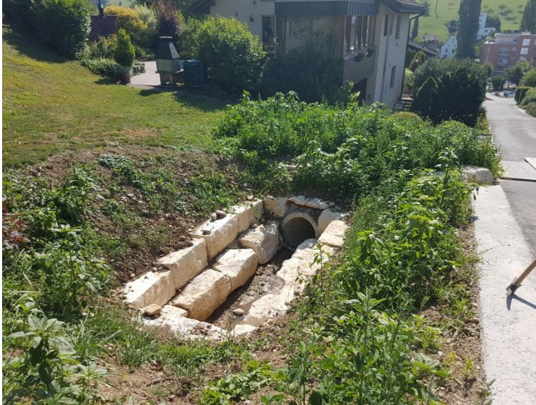
Abbildung 2: Neu gebaute, seitliche Einlauföffnung am Aspmetgraben (vgl. Abbildung 1)
