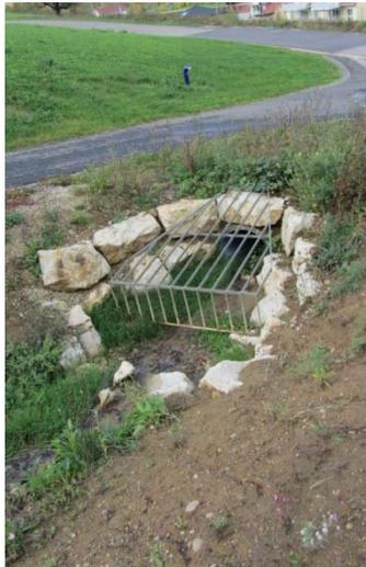
Foto 3 Einlauf mit Rechen in die neue Leitung, Durchmesser 60 cm
