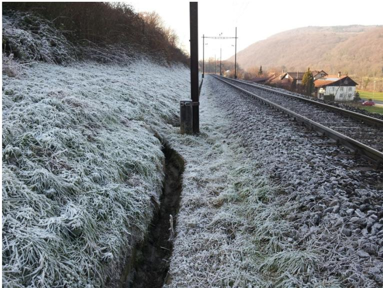
Abbildung 7 Entwässerungsrinne entlang der Bahngeleise (hier mit Engstelle Pfosten Fahrleitung)
