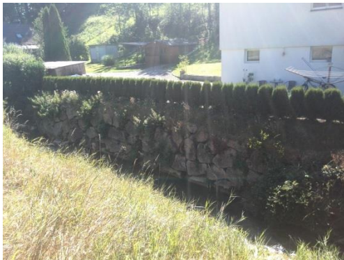
Abbildung 11: Massnahme 15 Mauer mit formwilden Natursteinen neu aufgebaut: ausgeführt
