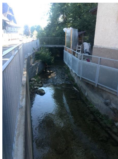
Abbildung 10: Massnahmen 11, 12, 13, 14 Alter Übergang abgebrochen, neue Stützmauer links, neue Betonplatte und Absturzsicherung mit Vollfüllung rechts: ausgeführt
