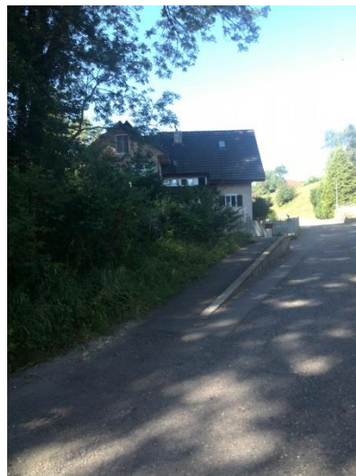
Abbildung 8: Massnahme 9 Neue Rampe: ausgeführt
