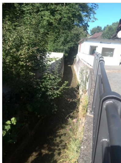
Abbildung 6: Massnahme 5 (gegen Fließrichtung) Überdeckung entfernt: ausgeführt
