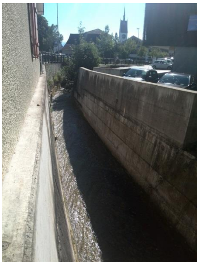
Abbildung 3: Massnahme 1 Mauer erhöht, Objektschutz Post: ausgeführt
