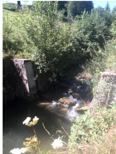
Abbildung 14: Massnahme 19 (gegen Fließrichtung) Mauer des Kiessammlers ausgeschnitten: ausgeführt
