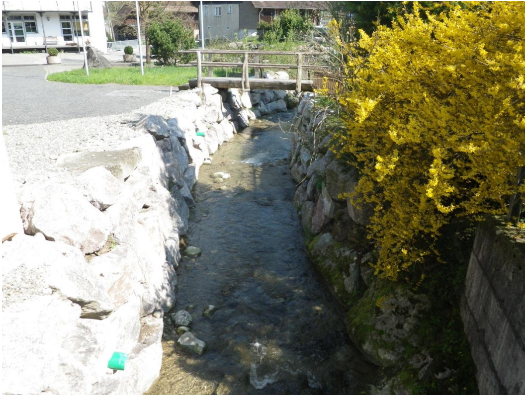
Foto 5: Fussgängerbrücke Bünt über den Wissenbach, Blick in Fließrichtung
