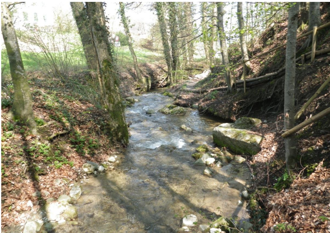
Foto 2: Wissenbach in der Tobelstrecke kurz oberhalb von Benzenschwil, Blick in Fliessrichtung. Äste und Baumstämme in Gerinnenähe (rechts) sind vom Unterhalt zu entfernen.
