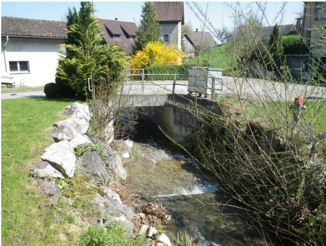
Foto 4: Brücke Büntweg über den Wissenbach, Blick in Fließrichtung
