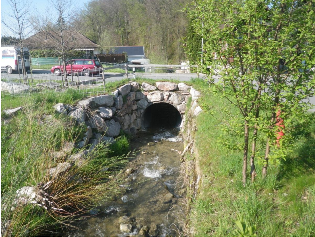
Foto 9: Durchlass Hauptstrasse des Wissenbachs, Blick in Fliessrichtung
