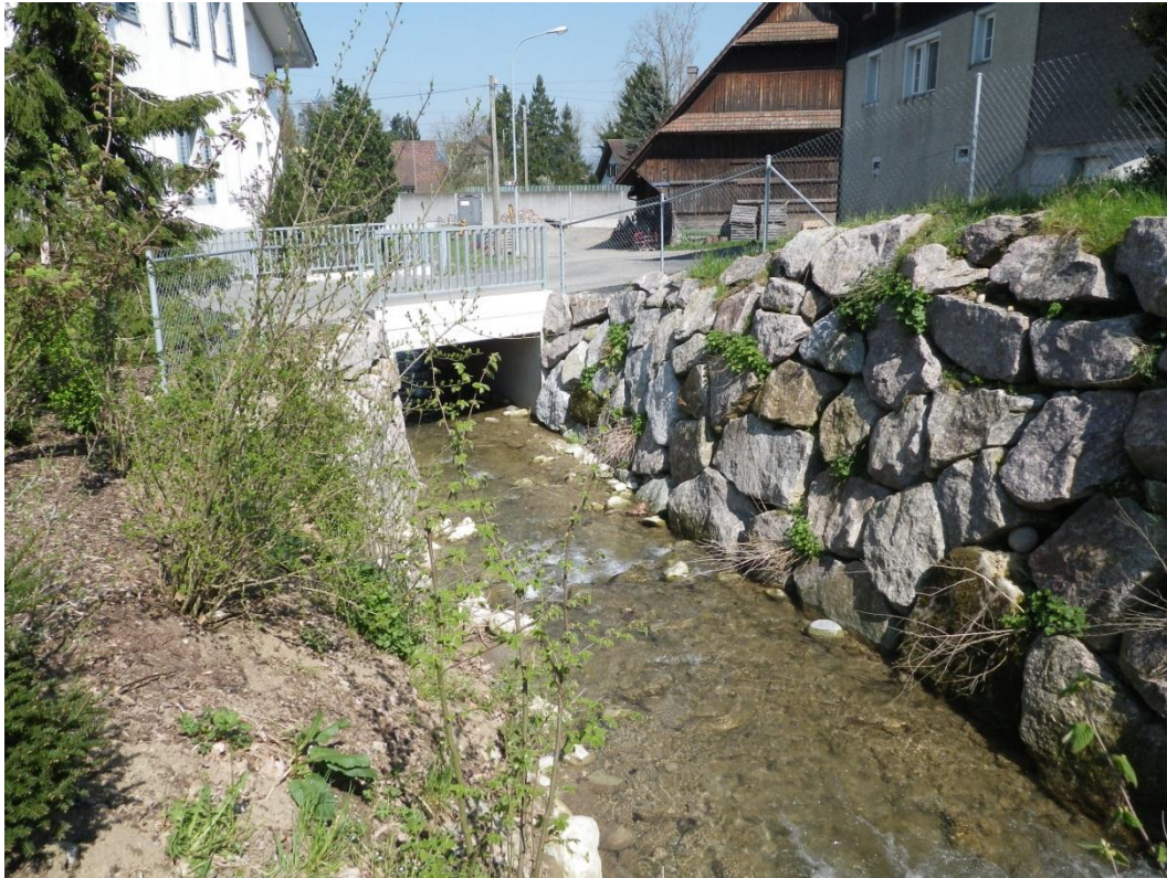
Foto 7: Durchlass Chäsiweg des Wissenbachs, Blick in Fließrichtung
