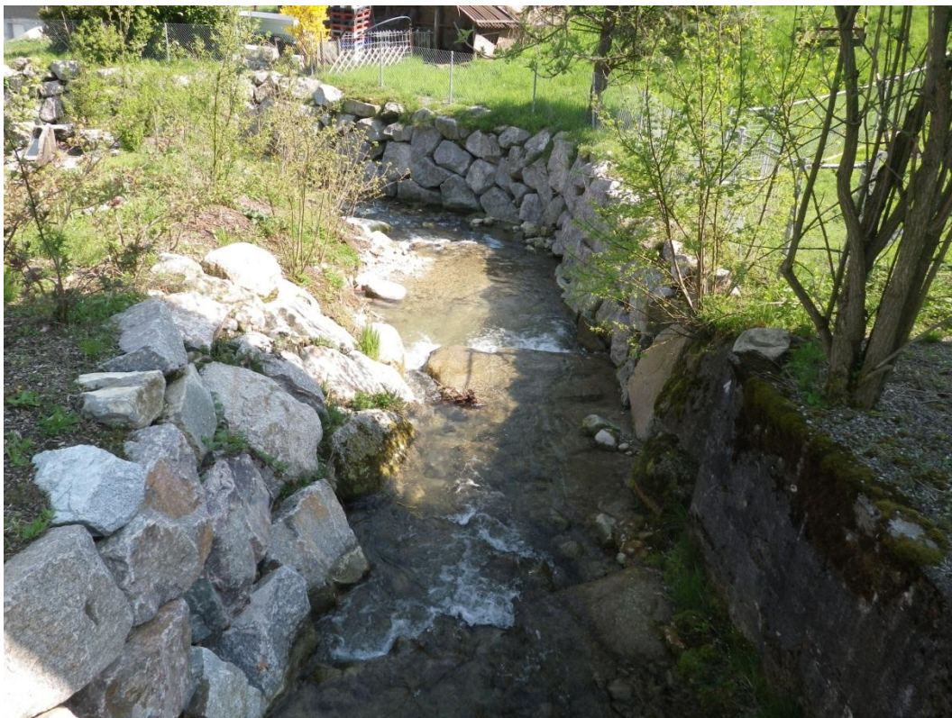
Foto 6: Blick von der Fussgängerbrücke Bünt in Fließrichtung des Wissenbachs. Neue Ufermauer rechts und abgebohcstes Ufer links
