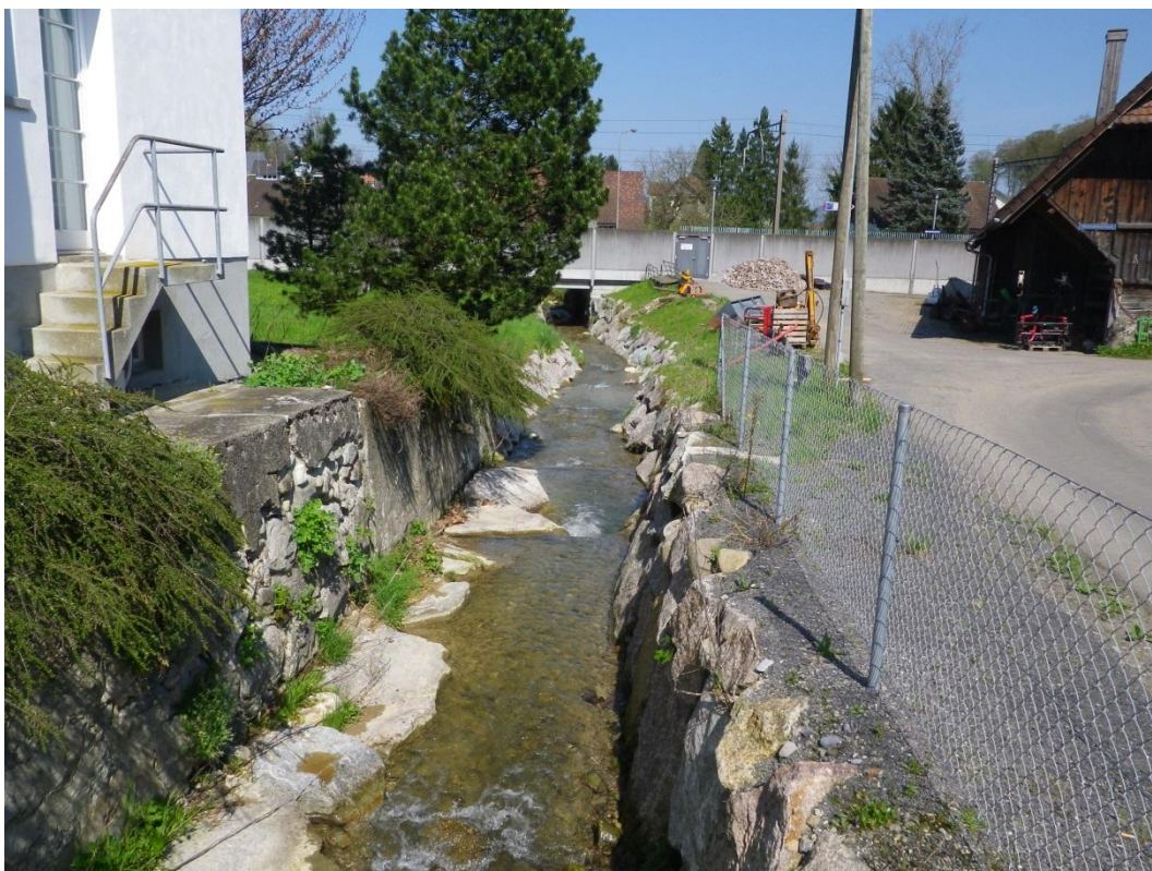
Foto 8: Bachabschnitt des Wissenbachs ab Durchlass Chäsiweg bis Durchlass SBB, Blick in Fließrichtung
