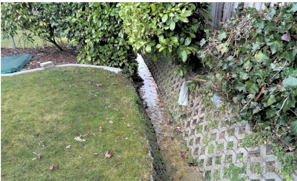
Abbildung 7: Blick in Flussrichtung bei AN-286. Das linksseitige Ufer bietet kaum Freibord. Zudem ist dieser Abschnitt monoton und naturfremd ausgebildet
