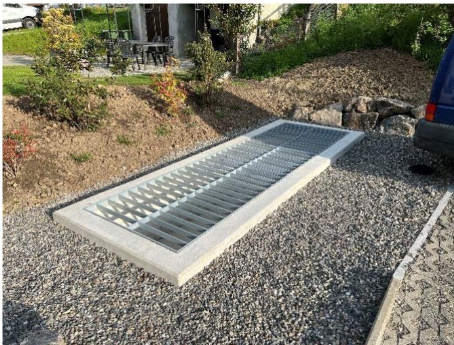
Abb. 3: fertiggestelltes Einlaufbauwerk
