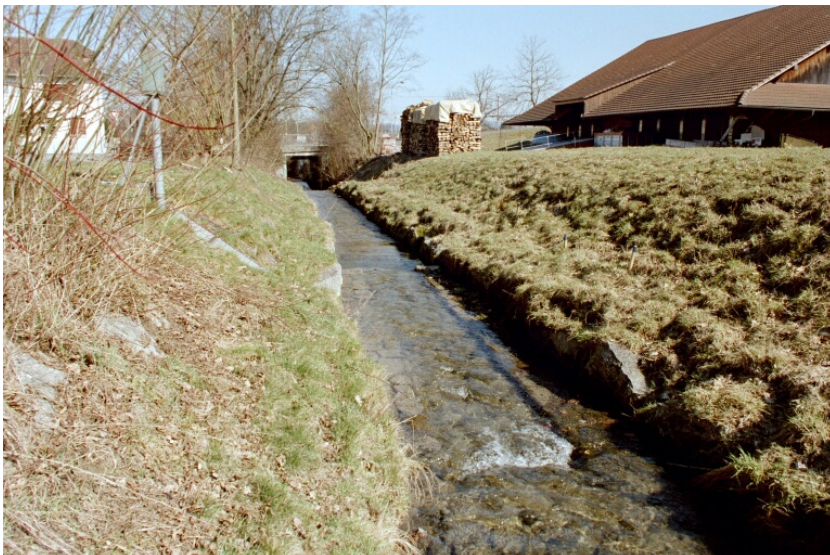
Abflussmessstation 352 Katzenbach – Muri 14. März 2003 / ry
