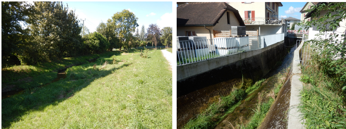
Abb. 2: Blick auf die Bünz, Links: aufgeweiteter Bereich, Rechts: erhöhte Ufermauern vor dem Durchlass Zürcherstrasse.
