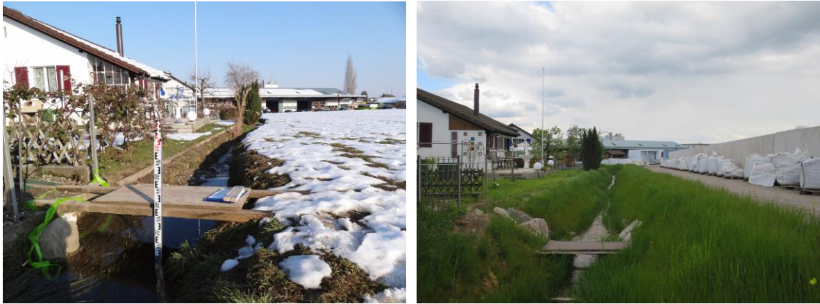
Abb. 3: Massnahmen am Riedmisbächli unterhalb Kantonsstrasse: Gerinne vor Massnahmen (links) und nach Massnahmen (rechts).
