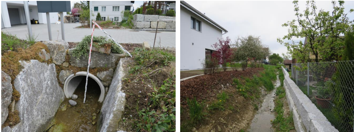
Abb. 6: Vergrösserter Durchlass „Breite“ (links) und neuer Stellriemen entlang Parzellen Sarbachstrasse (rechts).
