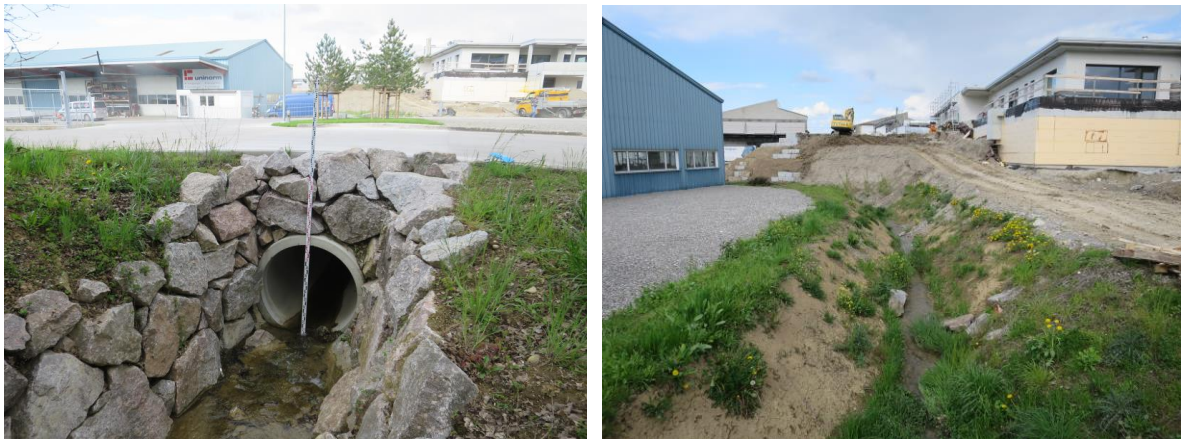
Abb. 4: Massnahmen am Vordermattenbächli: Neuer Durchlass Schiblerweg (links) und offenes Gerinne unterhalb Schiblerweg (rechts).
