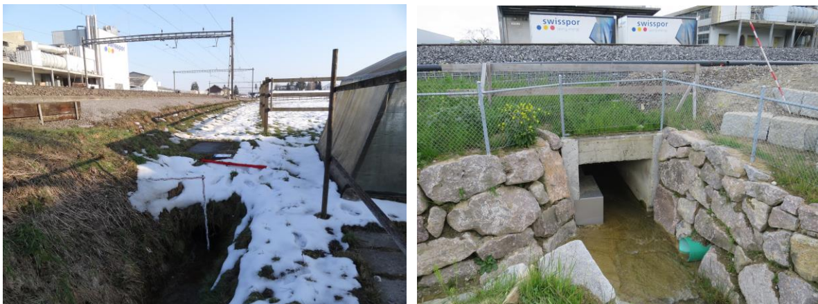
Abb. 5: Massnahmen am SBB-Durchlass: Einlaufbereich vor Massnahmen (links) und nach Massnahmen (rechts).
