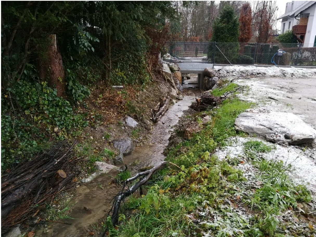
Abbildung 4: Aufnahmen in Fließrichtung: Böschungssicherungen, Blick zum neuen Durchlass D4 (siehe Tabelle 1)
