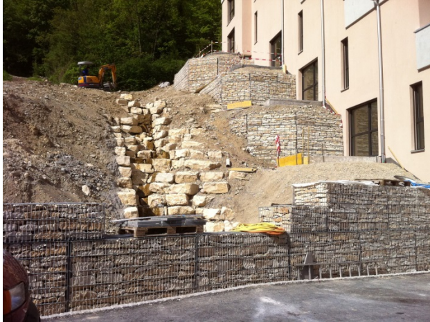
Abbildung 2 Neues Gerinne des Müseggbachs oberhalb der Erschliessung Trottenareal (2013)
