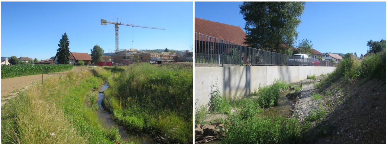
Ausgebaute Gewässerabschnitte am Krebsbach in Hendschiken
