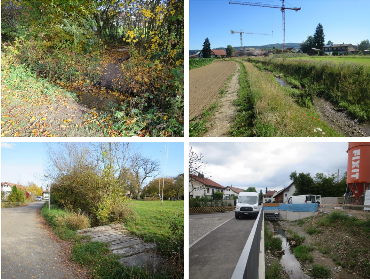
Abb. 3: Ausbau des bestehenden Gerinnes am Krebsbach (links vor Massnahmen im Jahr 2015, rechts nach Massnahmen im Sommer 2017). Oben: Gerinne zwischen dem Bahndamm und der Strasse „Am Bach“, unten: Entlang der Strasse „Am Bach“.
