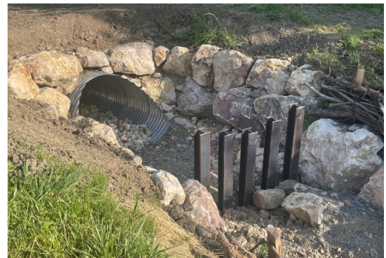
Foto 4, Schwachstelle de-str-3 mit Schwemmholzrechen, Blick in Fließrichtung
