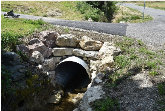
Foto 1, Schwachstelle de-str-2, Blick gegen Fließrichtung, Beginn Wasserbauprojekt
