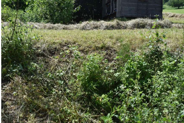
Auslaufbereich Durchlass, Blick gegen Fliessrichtung, Quelle: Feldbegeung Ingenias AG
