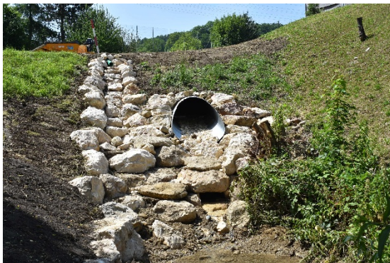
Foto 5, Auslaufbereich Schwachstelle de-str-3, Blick gegen Fließrichtung
