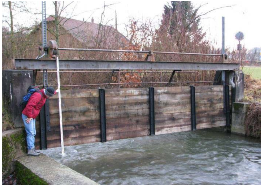
Abb. 10 Regulierschütz am Einlauf zum Tych.
