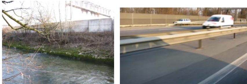
Abb. 14 Lärmschutzwände zwischen der Wigger und der Autobahn.
