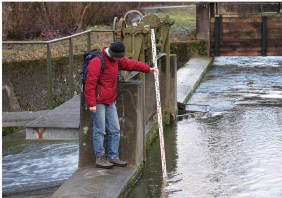
Abb. 11 Seitenentlastung vor dem Regulierschütz zum Tych.
