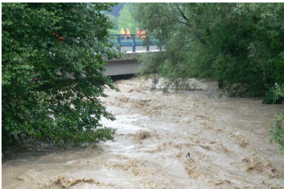
Abb. 6 Hochwasser der Wigger im August 2005 bei der Hofmattstrasse Aarburg.
