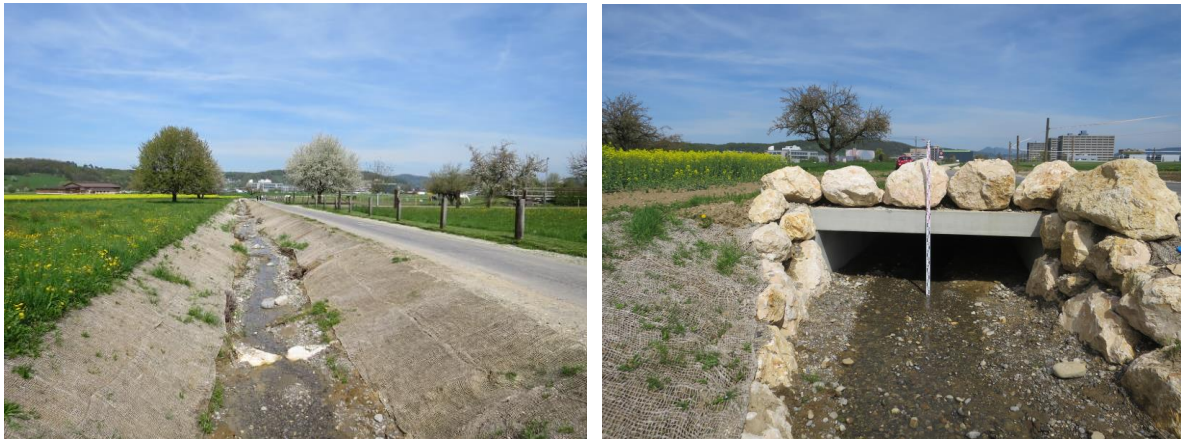
Abb. 2: Bachlauf im Abschnitt 1, Links: entlang der Zwinglistrasse, Rechts: Durchlass Ziegelhofstrasse.
