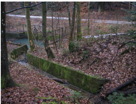
Buechwaldbach vor Massnahmen
