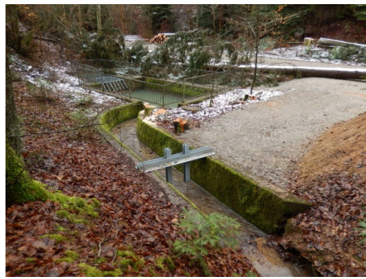
Buechwaldbach mit Grobrechen
