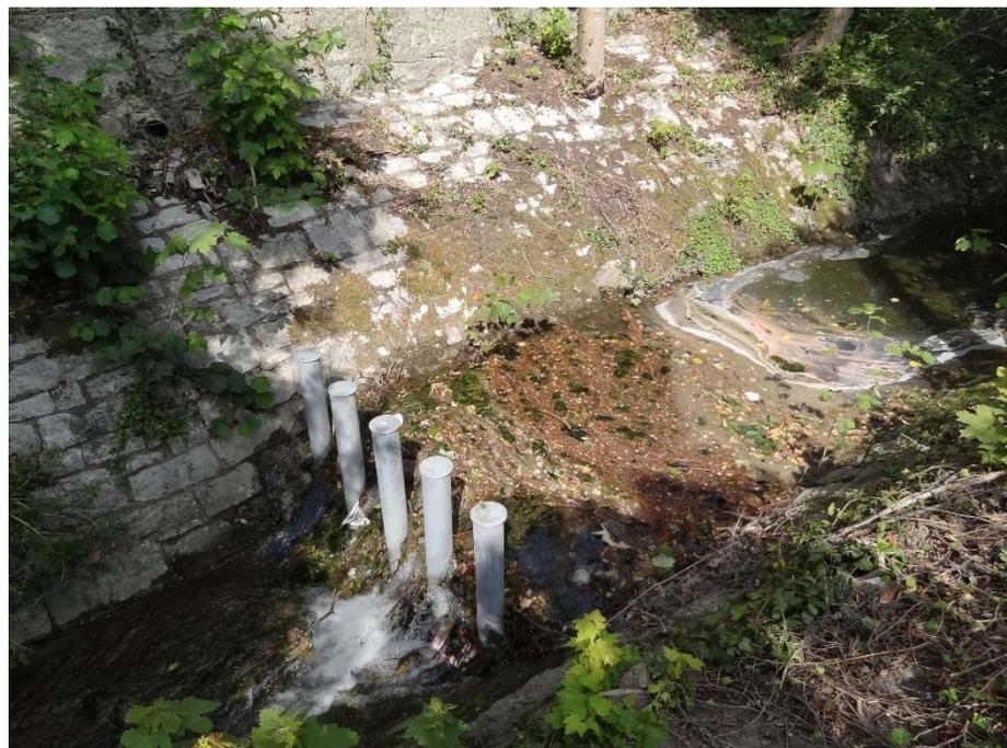
Abb. 4: Neuer Rechen kurz unterhalb der Brücke Renggerstrasse
