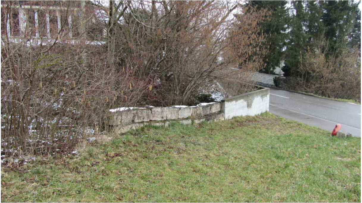
Foto 6 Bestehender Durchlass bei der Aarauerstrasse
