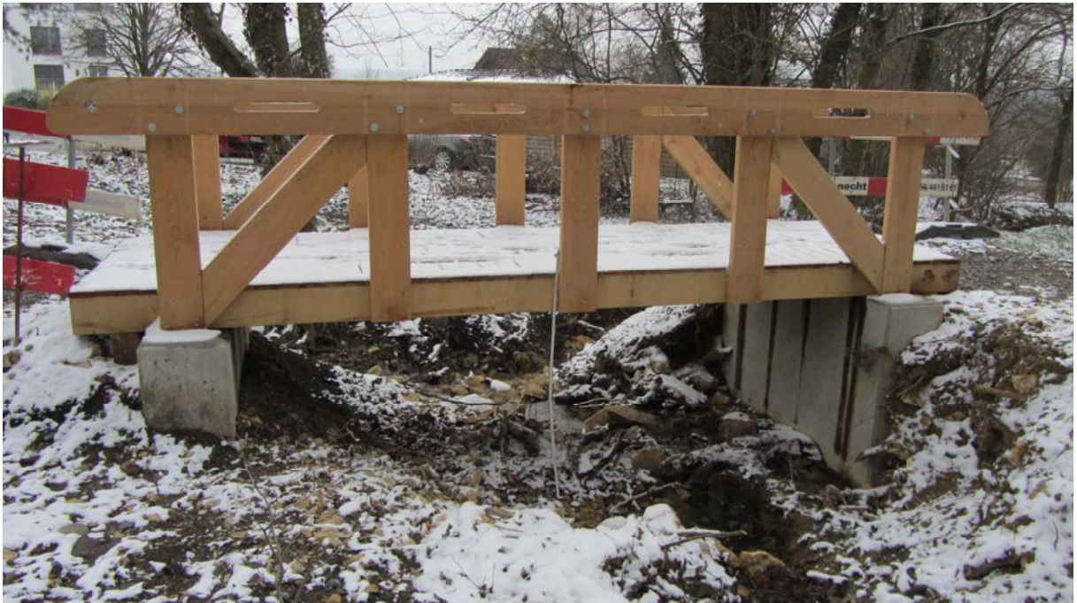
Foto 3 Ersatz des Durchlasse durch eine Holzbrücke
