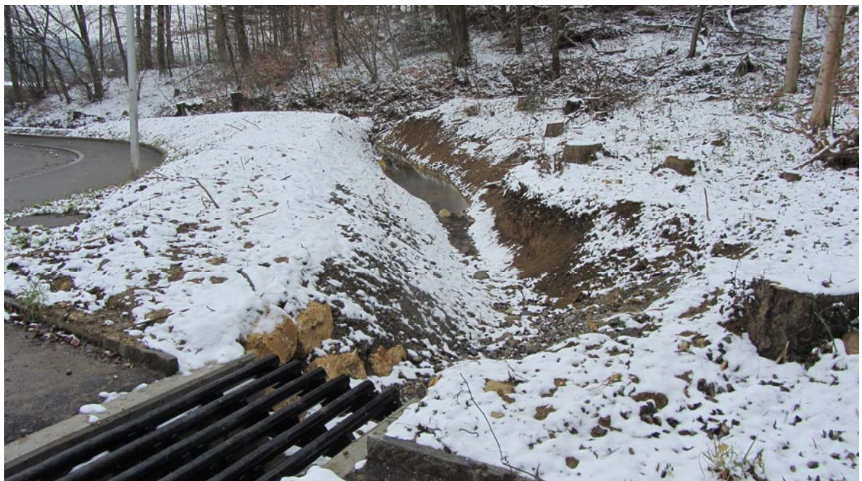
Foto 1 Neues Gerinne mit Auffangdamm beim Chesletenrain
