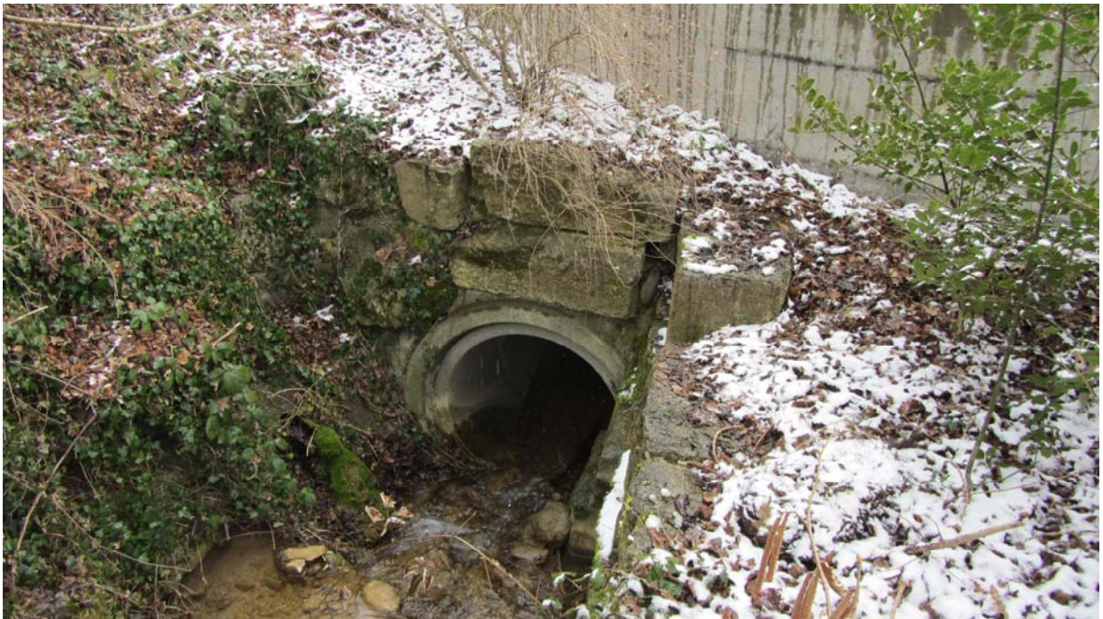
Foto 7 Bestehender Durchlass bei der Aarauerstrasse
