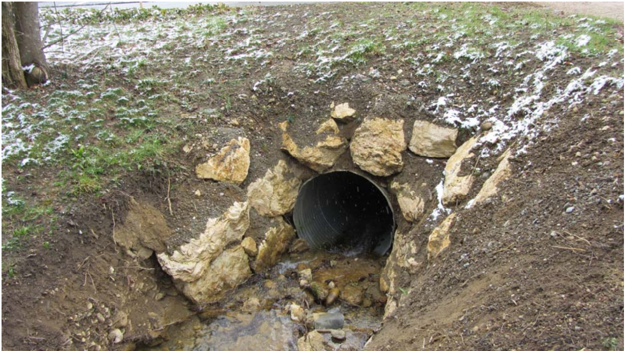
Foto 5 Neuer Durchlass bei der Kirchbergstrasse
