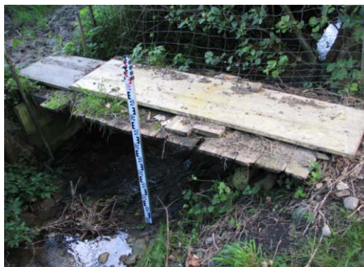
Abb. 4 Brücke mit Zaun am Erlibach in Veltheim.
