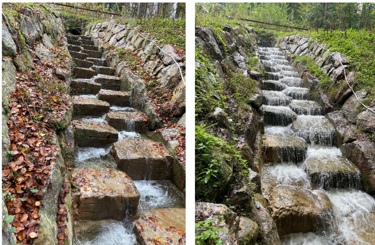
Abbildung 12: Bauwerk zur Längsvernetzung mit 28 Treppenstufen (links: Bild vom 25.11.2022 bei Niederwasser, rechts: Bild vom 29.9.2022 bei erhöhter Wasserführung mit Überströmung der Blöcke). Oberhalb des Bauwerkes fliesst der Bach durch einen kurzen Durchlass (Strassenüberführung).
