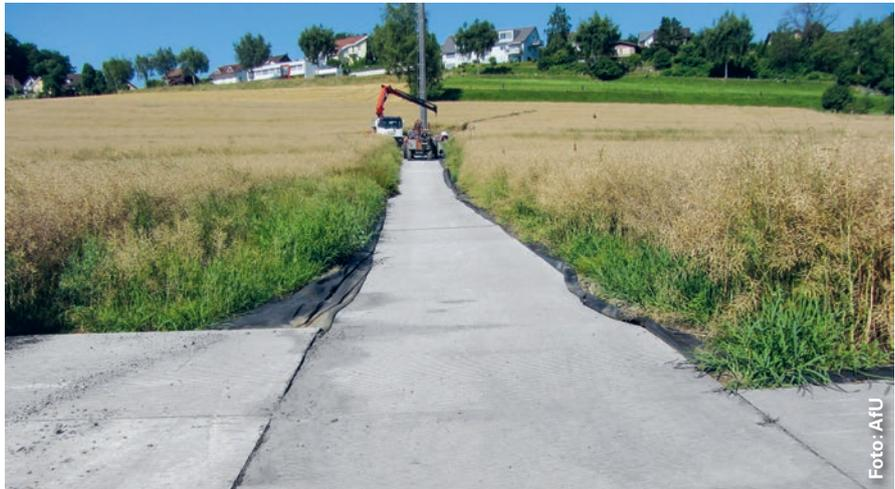
*Je nach Dauer der Baustelle, Witterung, Anzahl Überfahrten und Geländeform eignet sich ein anderer Typ von Baupiste. Für den Ersatz eines Betonmastes einer Stromleitung wurden hier durch das Elektrizitätswerk und die bodenkundliche Baubegleitung zusammen mit dem Unternehmer anstelle einer Kiespiste Aluminiumplatten verlegt. Im vorliegenden Fall hat sich dieses System aufgrund der wenigen Überfahrten und der sehr kurzen Zeitdauer bewährt.*
