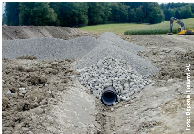
Aufbau einer zweilagigen Entwässerungshilfe (Füllung mit Rundkies 30/50 und Abdeckung mit 8/16) auf Niveau Rohplanie, anschliessend wird der Unterboden aufgetragen.
