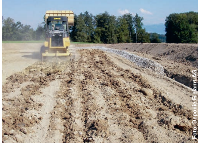
Die Rohplanie wird mit einem Aufreisszahn gelockert, um eine kapillare Trennschicht vermeiden zu können.
