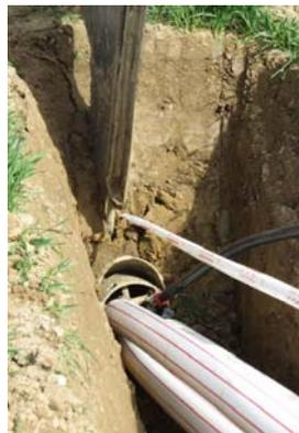
*Bildserie: Boden- und strukturschonendes Einpflügen von Stromleitungen. Ausser in den Start- und Zielgruben findet kein Bodenaushub statt. Im Bereich der Pflügung kann der Boden nach dem Einpflügen ohne Folgebewirtschaftungsphase wieder genutzt werden.*
