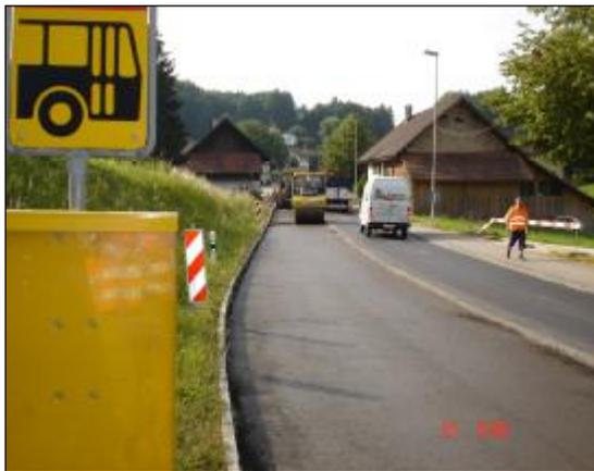
◀ Bei diesem Projekt wurde nur eine Strassenhälfte mit KMF <22 mm eingebaut, gefolgt von einer Binder- und Deckschicht. Die andere, rechte Strassenhälfte erhielt einen konventionellen Aufbau mit Fundationsschicht, Trag-, Binder- und Deckschicht!
