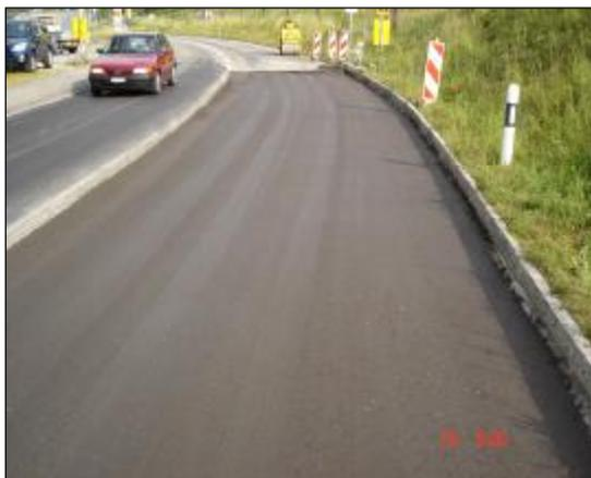
◀ Mit den gleichen Einbaugeräten kann bei kleineren Objekten am selben Tag oder am nächsten Arbeitstag die Trag-, Binder- und Deckschicht eingebaut werden!
