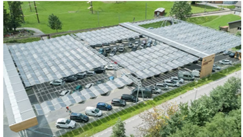
Das Erste über einer Parkfläche – 429 kWp Luftseilbahn Kronberg, 2020
