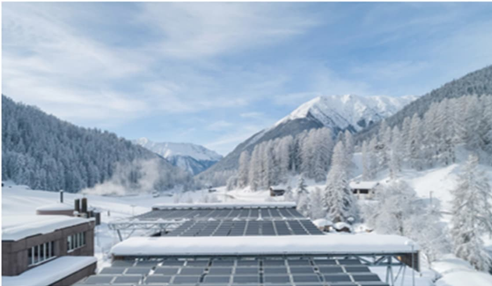
Das erste hochalpine Solarfaltdach – 252 kWp ARA Davos, 2022
