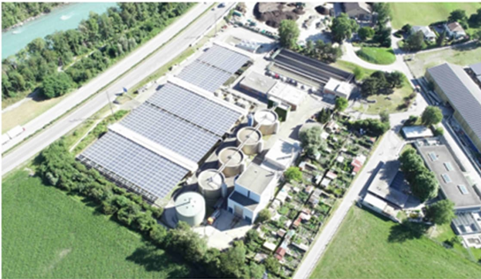
Pilotprojekt ARA Chur – 643 kWp 2017/2018
