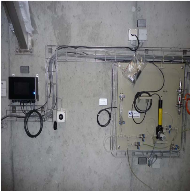
Für den Betrieb der Ozonierung über die SAK-Messung ist eine funktionierende Messung sehr wichtig. Eine konventionelle SAK-Messung im Zulauf und Ablauf der Ozonanlage sollte eine mechanische Reinigung aufweisen. Ansonsten wird der Wartungsaufwand zu gross.
