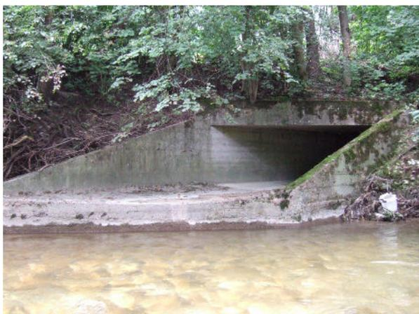
Abb. 28: Einleitung der Hochwasserentlastung RA1B in die Wigger. Koordinaten: 636'688 / 239'084
