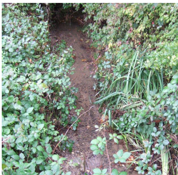
Abb. 11: Stelle E061 oberhalb der Einleitung des Regenbeckens „Balzenmatt“ bei Riniken. Koordinaten: 656'880 / 261'311.
