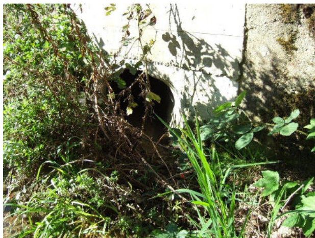
Abb. 38: Einleitung FK & SA "Schulhaus" aus der Regenwasserbehandlungsanlage bei Schinznach-Dorf.
