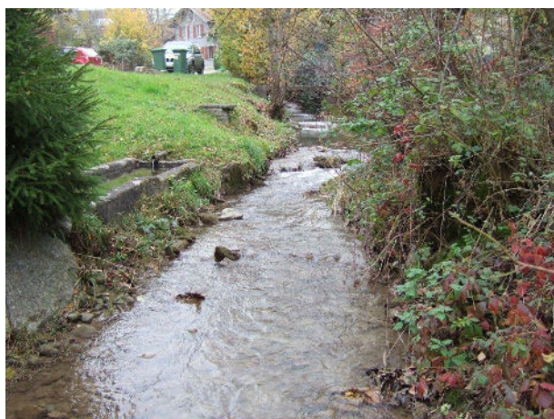
Abb. 51: Stelle E079 unterhalb der Hochwasserentlastung HE2 und oberhalb der geplanten Regenwasserbehandlungsanlage RB 2 in Küttigen. Koordinaten: 646'034 / 251'586.
