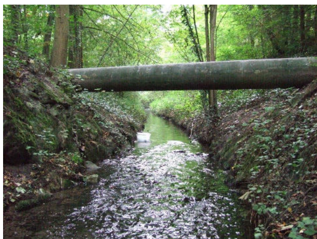
Abb. 26: Stelle E073 oberhalb der Einleitung des Fangbeckens „Unterer Schachen“ bei Schinznach Bad. Koordinaten: 654'750 / 255'902.
