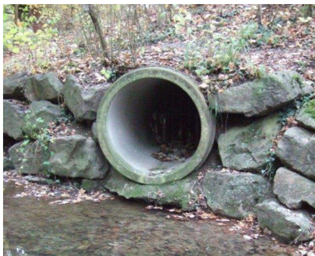
Abb. 20: Einleitung RB „Weihermatt“ aus dem Regenklärbecken bei Windisch.
