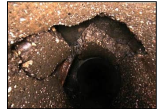
Undichte Kanalisation
