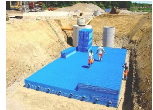
Versickerung ohne Bodenpassage
