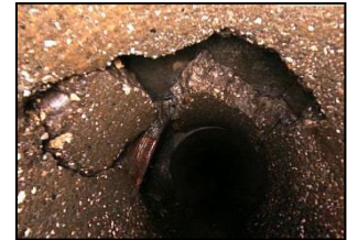
Undichte Kanalisation
