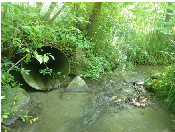
Abb. 8: Einleitung der Entlastung aus dem Regenbecken RUB Stampfi, Zofingen. Koordinaten: 2640178 / 1238882.
