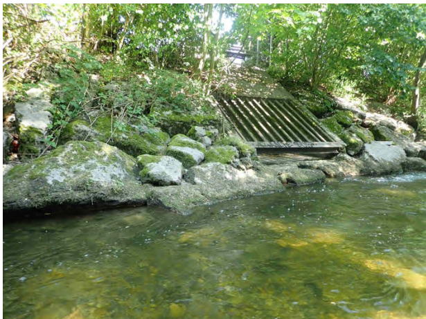
Abb. 13: Entlastung des Regenbeckens RUB BZZ, Zofingen in die Wigger. Koordinaten: 2637727 / 1236716.
