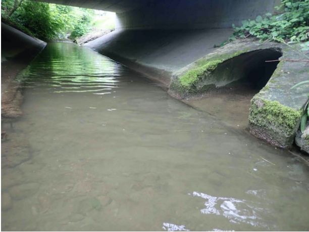
Abb. 22: Einleitung aus dem Regenüberlauf RA 463, Villmergen, in den Hinterbach. Koordinaten: 2661078 / 1244527.
