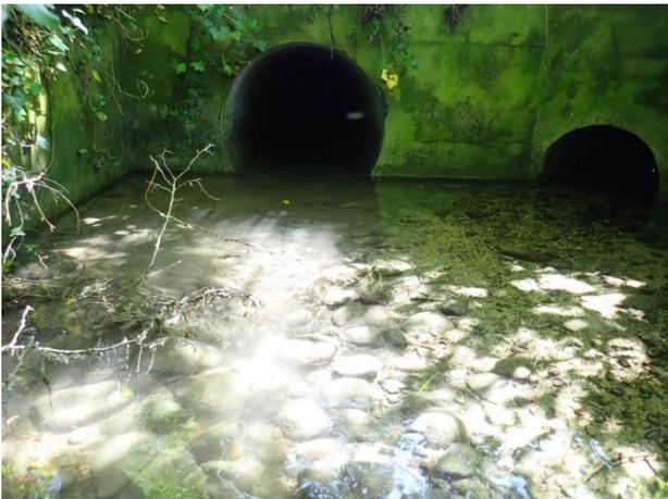
Abb. 7: Einleitung aus dem Regenbecken RUB Auenschachen in den Binnenkanal. Koordinaten: 2654573 / 1252437.
