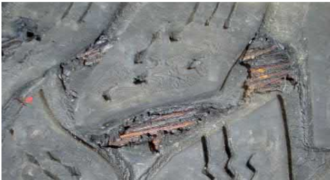
Stahlgürtel und Abdecklage sichtbar.
