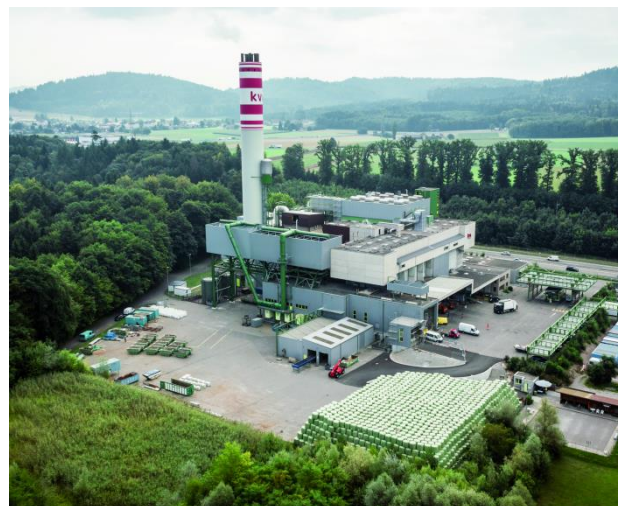
Abbildung 22. KVA Buchs mit Ballenlager für Kehrlicht (Foto: KVA Buchs).
