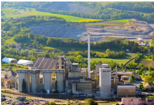
Abbildung 16. Zementwerk Wildeggen der Jura-Cement-Fabriken (Foto: JCF).
