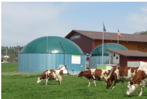
Abbildung 18. Eine von vier Co-Vergäranlagen im Aargau (Foto: agrino, Remetschwil). In Co-Vergäranlagen werden sowohl Gülle aus der Tierhaltung als auch biogene Abfälle eingesetzt.
