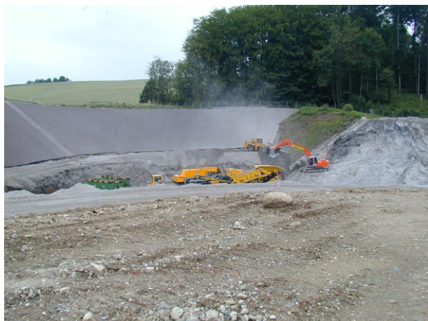
Abbildung 8. Einbau von KVA-Schlacke in der Deponie Seckenberg in Frick.
