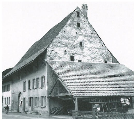
Giebelseitiger Nebenbau mit Pultdach
