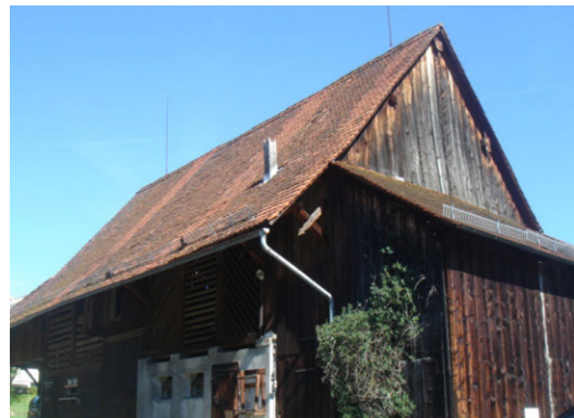
Giebelseitiger Nebenbau mit Pultdach
