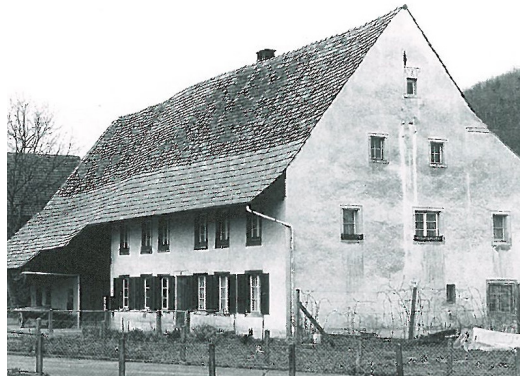
Lage der Fenster unter dem Vordach
