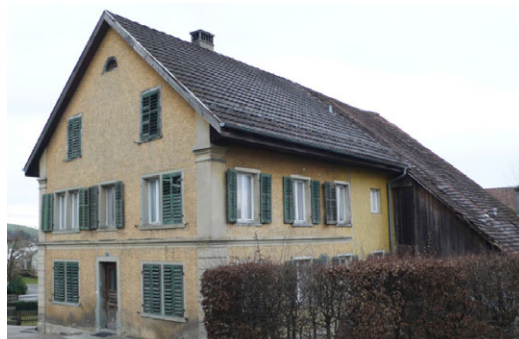
Nebenbau unter der Verlängerung des Satteldaches
