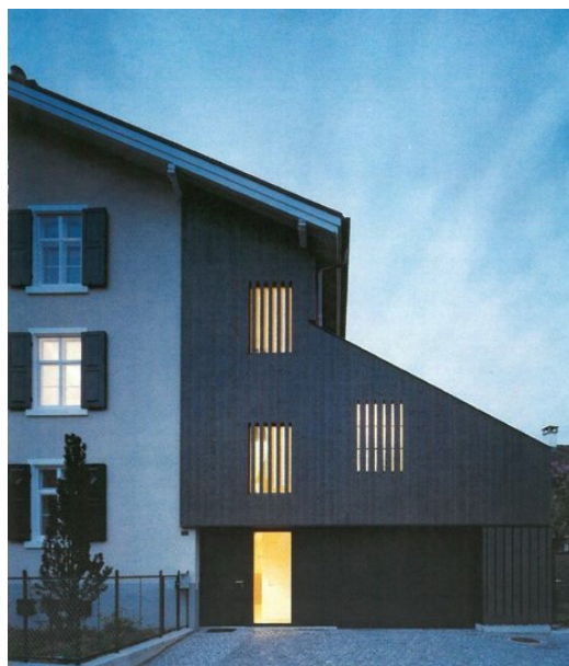
Beispiel Nebenbau mit Verblendung und differenzierten Fassadenmaterialien (Architekt: weberbueess Architekten SIA, Fotografie: Ruedi Walti Fotografie)
