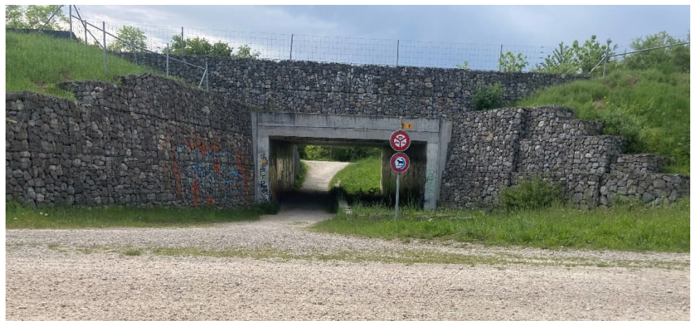
Abb. 21: Bestehender Durchlass unter der Staffeleggstrasse hindurch (Quelle: MRR)
