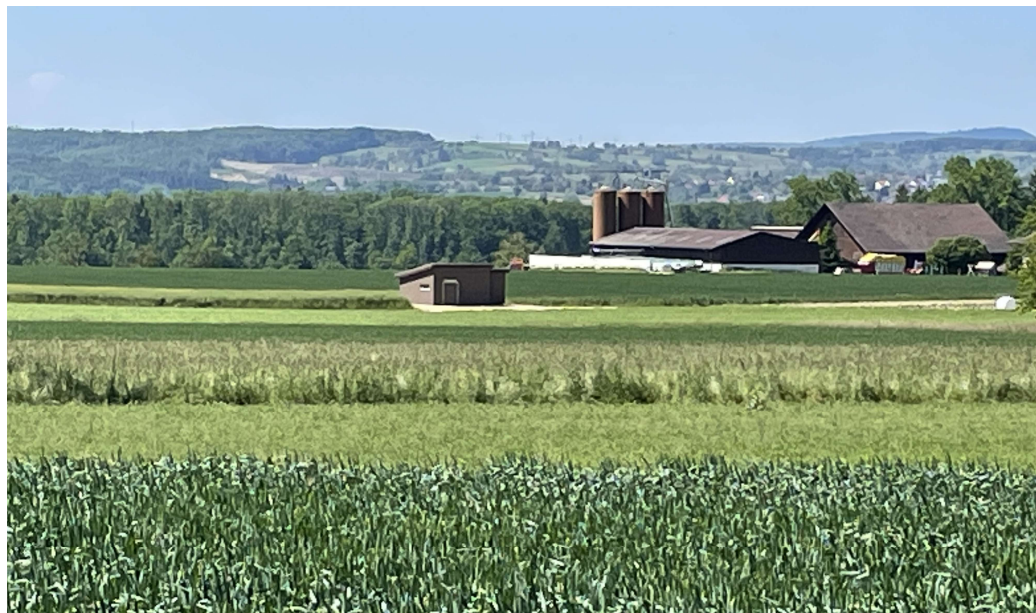
Abbildung 14: Beispiel Pumpstation «Bäumli 2», farblich in Umgebung integriert
