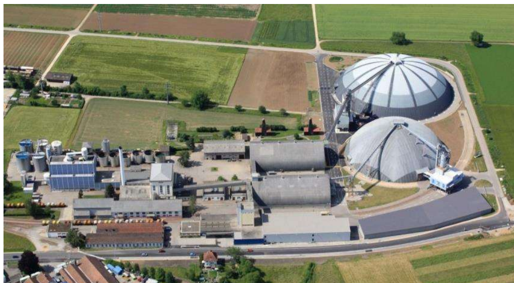
Abbildung 2: Saline Riburg mit rechts Saldome 1 und 2 (Holzkuppelbau; Lagerkapazität rund 180'000 t)
