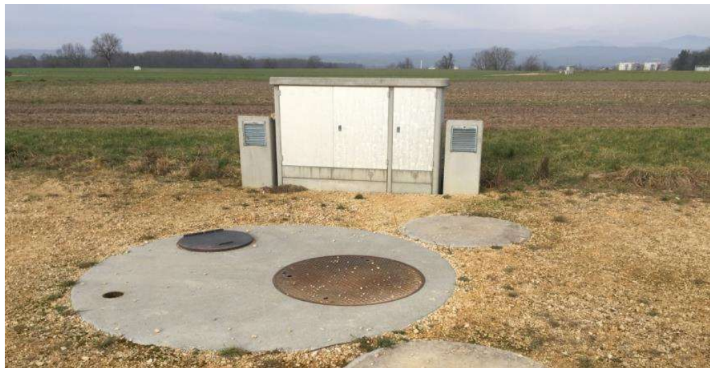
Abbildung 21: Bohrplatz während Betriebsphase (Oben: Schema)
