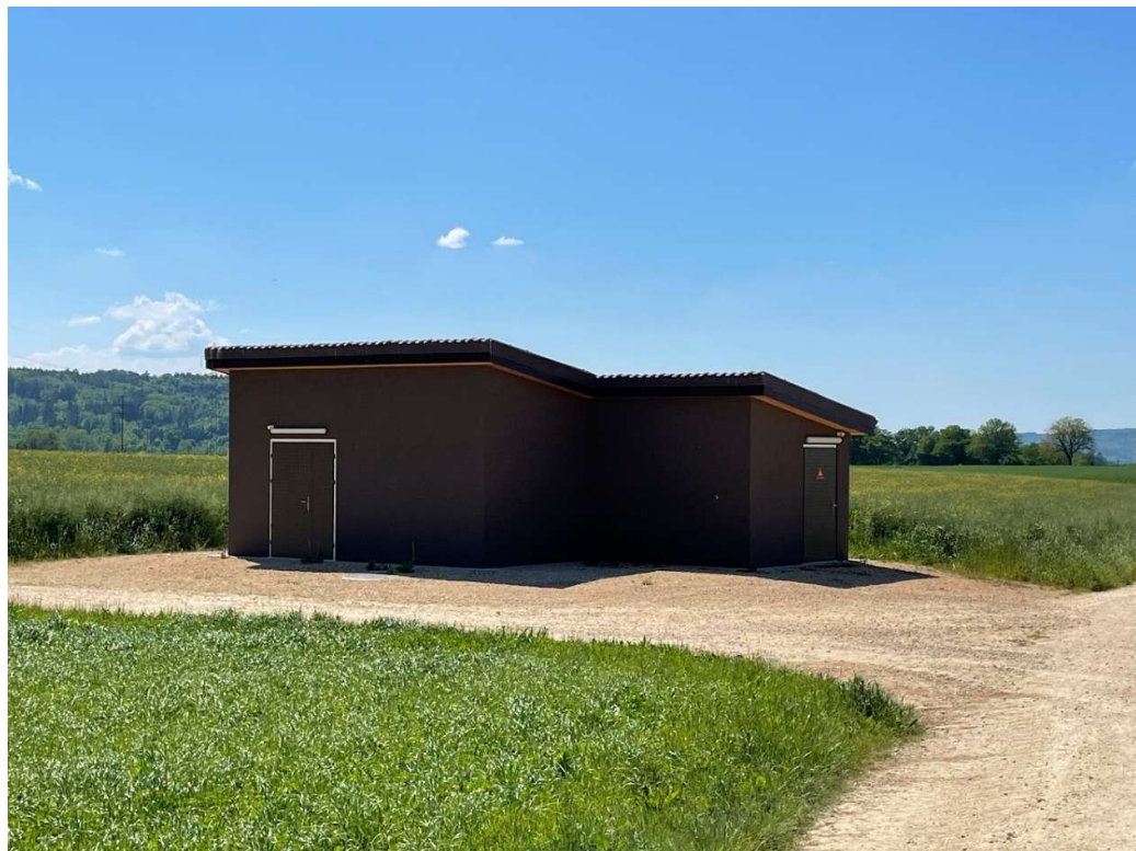
Abbildung 13: Beispiel Pumpstation «Bäumli 2»
