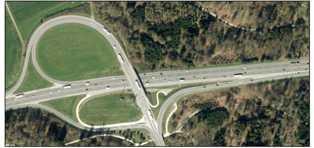
Abbildung 4: Neue Einfahrtsrampe auf die A1 nach Zürich
