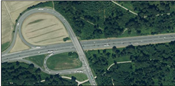
Abbildung 3: Anschlussknoten vor dem Umbau
