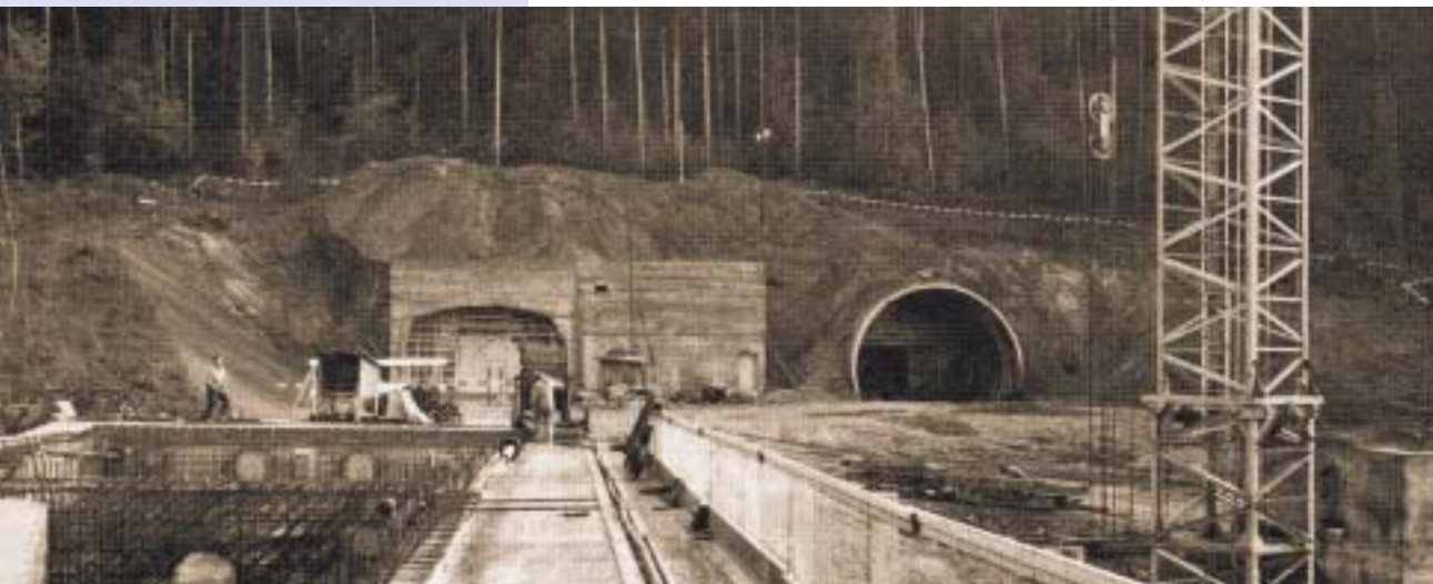
Westportal des Tunnels und die im Bau befindliche Autobahnbrücke Dättwil (Quelle: "Der Aargau baut", 1968)
