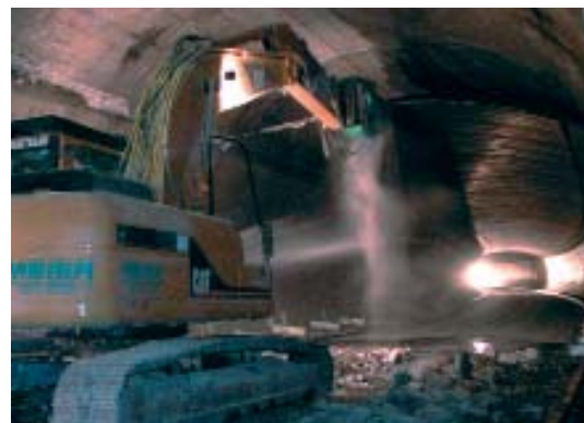
Abbruch der Zwischendecke im Beton-Beiss-Verfahren (Foto C. Stocker)
