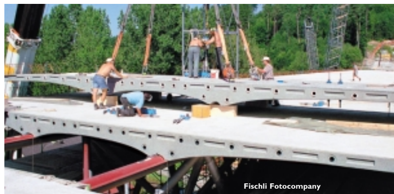
Montage eines Beton-elementes der Fahrbahn-
