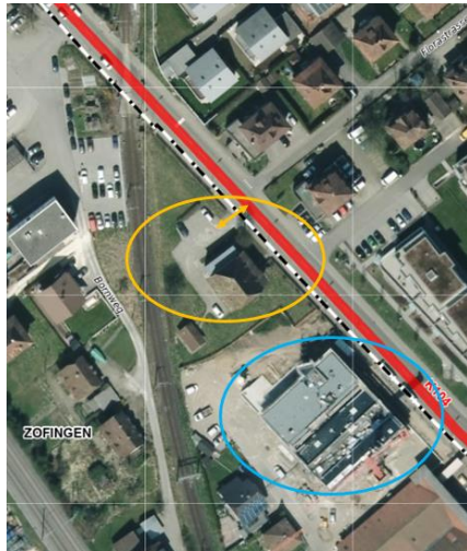
3.3 Abbildung 5: Luftbild aus dem Jahr 2015. Das Siechenhaus (orangener Kreis) ist direkt von der K104 erschlossen (orangener Pfeil). Das Gebäude auf Parzelle 328 (blauer Kreis) ist noch im Bau.
