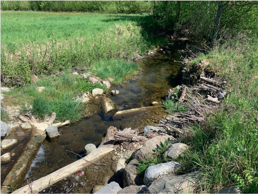
Abbildungen 18 und 19: Aufwertung des Stöckenbach (Südwestumfahrung Sins) während der Ausführung und im abgeschlossenen Zustand
