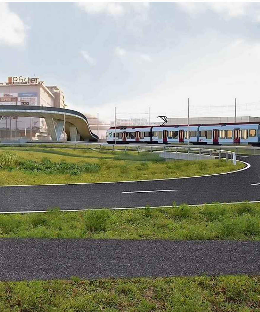
Siegerprojekt «Integral»: Links das Modell des 265 Meter langen Spannbetonbauwerks, oben die Visualisierung. Wer von Buchs herkommt, wählt für die Südfahrt die erste Ausfahrt aus dem Kreis, wer ins Dorfzentrum will, nimmt die zweite und fährt über die langgezogene, schlanke, leicht geschwungene Brücke am Möbel Pfister vorbei in Richtung McDo-nald's-Kreisel weiter. UW/ZVG
