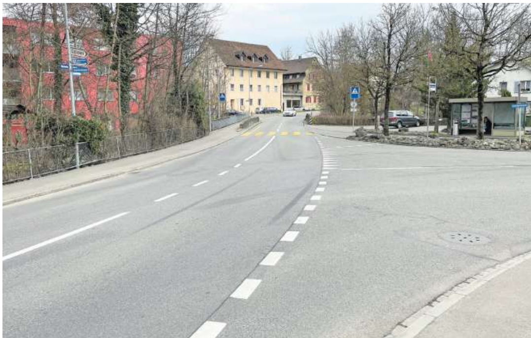
Die historische Aabachbrücke wird durch einen Neubau ersetzt.
