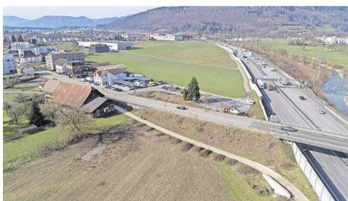
Die aktuelle Situation an der Wiggerbrücke.
