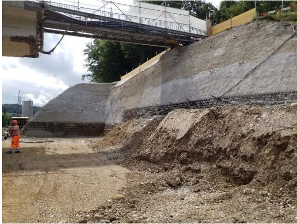
Baugrube Widerlager Habsburgbrücke
