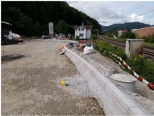
Randsteine Kreisel West
