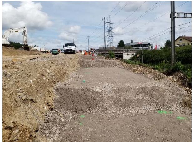
Erstellung Stützmauer Ausfahrt Hausen
