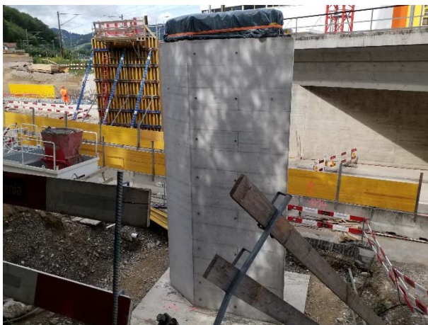
Pfeiler Wildschachenbrücke B-296
