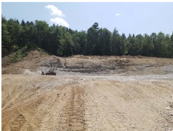
Abbau Geländesporn Areal Creabeton AG
