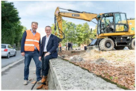
Rolf H. Meier, Kantonsingenieur und Stadthalb Philipp Ramoser prüfen die Baustreife vor dem Baubeginn.
